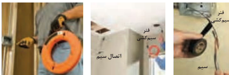
شکل ۳۷- چگونگی استفاده از فنر سیم‌کشی
