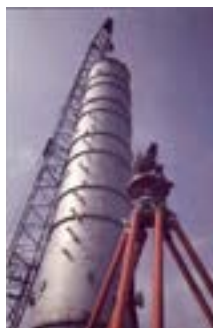
شکل ۶-۵ برج‌های استخراج مایع - مایع ستونی ایستا با سینی‌های غربالی
