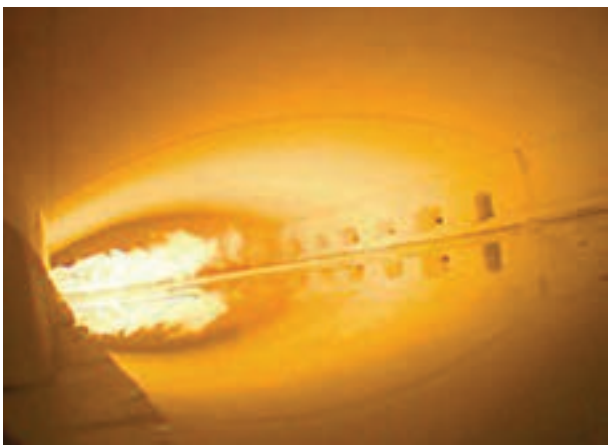
داخل مخزن ذوب کوره ریجنراتوری کنارگذر در حال کار
