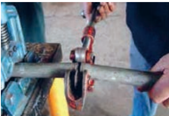
شکل ۲- بریدن لوله محاسبه شده
