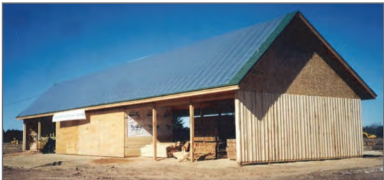
کوره ترکیبی خورشیدی و هوای آزاد Combined Air & Kiln drying building
