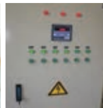
تابلو برق دارای کنتاکتور مخصوص برای هر دستگاه
