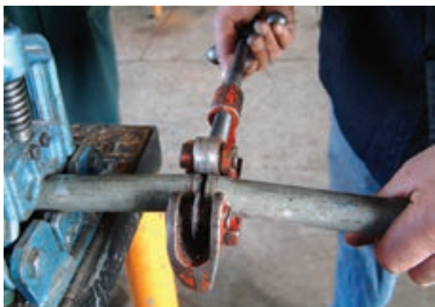
شکل ۳-۵۲- بریدن لوله‌ی محاسبه شده
