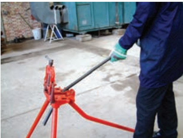
شکل ۳-۹- خم‌کاری لوله به وسیله‌ی گیره‌ی صحرایی
