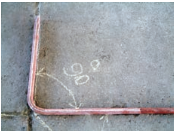
شکل ۳-۲۶- مقایسه‌ی لوله‌ی خم شده با گوشه‌های سنگ‌فرش کارگاه
