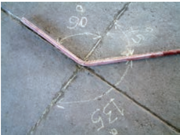
شکل ۲۹-۳- کنترل خم لوله‌های ۴۵ درجه
