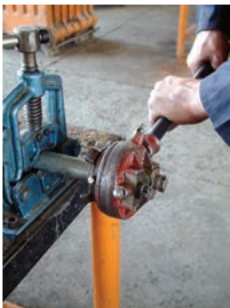
شکل ۳۴-۴- حدیده کردن لوله
