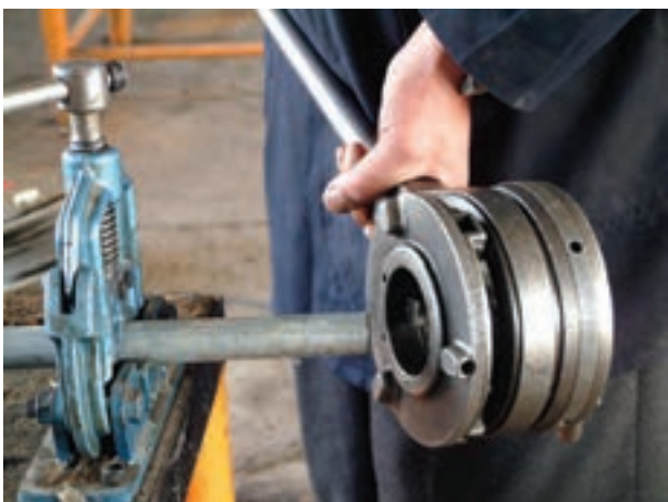
شکل ۴-۶۳- شروع حدیده کاری
