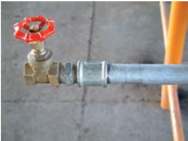
شکل ۴-۸- اتصال دنده‌ای
