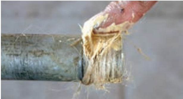
شکل ۱۰۰-۵- استفاده از مواد آب‌بندی
