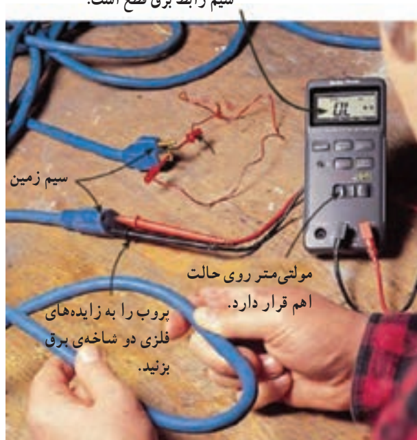
شکل ۲-۸۰ - آزمایش سیم رابط برق دستگاه.
