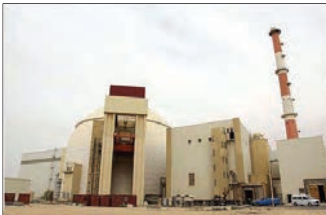
نیروگاه اتمی بوشهر
