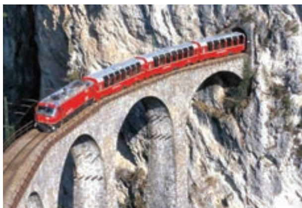
احداث تونل و پل برای عبور قطار در ناحیه‌ای کوهستانی و برف‌گیر - سوئیس
