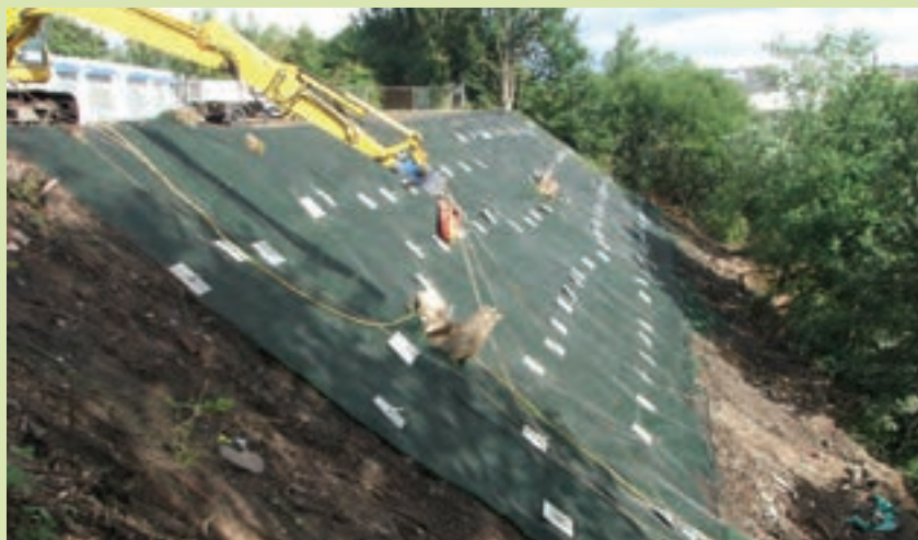
پایدارسازی شیب به روش میخ‌کوبی
