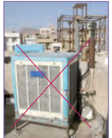
ب - فاصله بین دودکش تا کولر آبی و یا پ - برای خروجی دودکش هر دستگاه گاز سوز یک کلاhek H نصب شود. دریچه های تأمین هوای ساختمان دست کم سه متر باشد.
