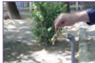
خ - آزمایش آب بندی شیر
