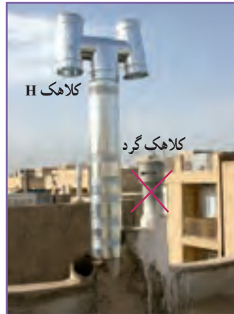
ب - فاصله بین دودکش تا کولر آبی و یا پ - برای خروجی دودکش هر دستگاه گاز سوز یک کلاhek H نصب شود. دریچه های تأمین هوای ساختمان دست کم سه متر باشد.
