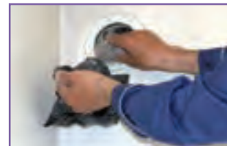
ب - فاصله بین دودکش تا کولر آبی و یا پ - برای خروجی دودکش هر دستگاه گاز سوز یک کلاhek H نصب شود. دریچه های تأمین هوای ساختمان دست کم سه متر باشد.
