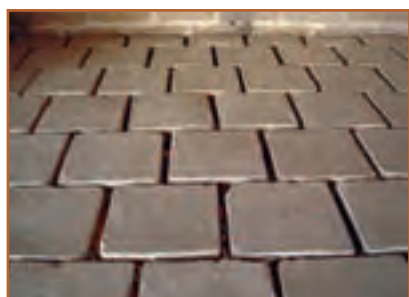
ب- استفاده از آجر برای کف
