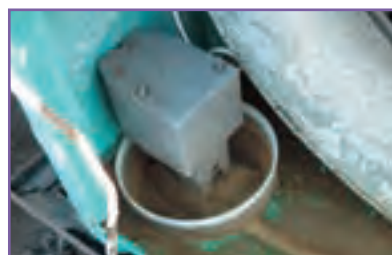
ج - بررسی و تمیز کردن پمپ آب
