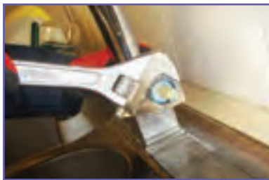
ث- باز کردن پیچ روی مغزی (گلند)
