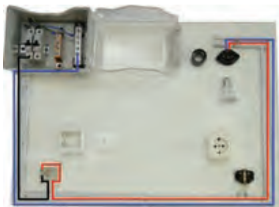
شکل ۸-۵ - انجام سیم کشی روشنایی
