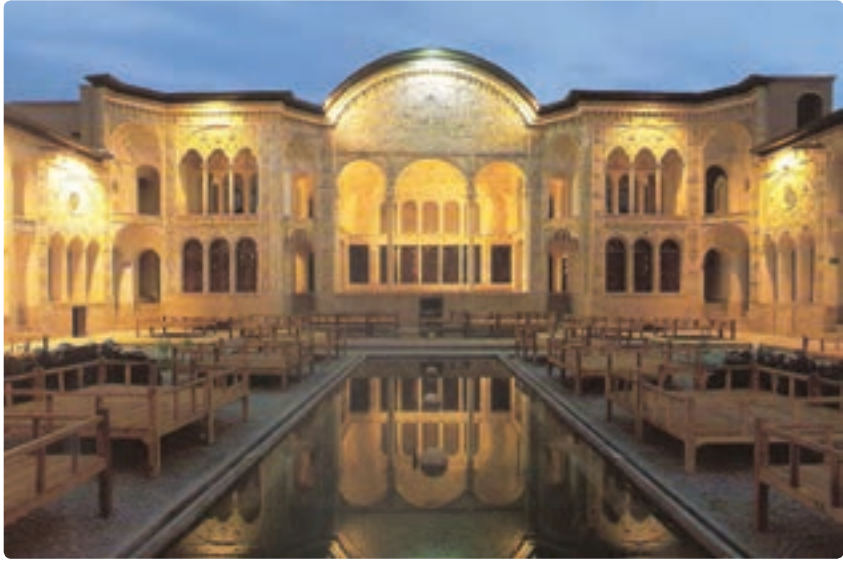
خانه طباطبایی ها در کاشان
