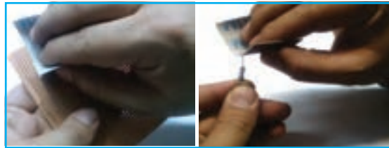
الف - تمیز کردن محل اتصال
