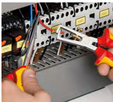
شکل ۹-۱- روکش برداری با سیم لخت کن دستی
