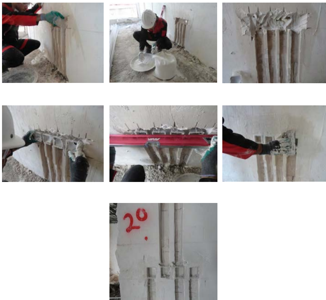
شکل ۲-۳۷- مراحل نصب قوطی کلید و پریرز
