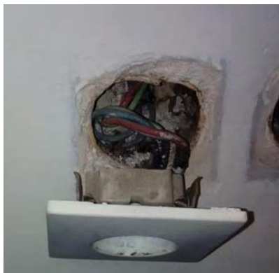
شکل ۵-۳- قاب جداشده پریز از دیوار
