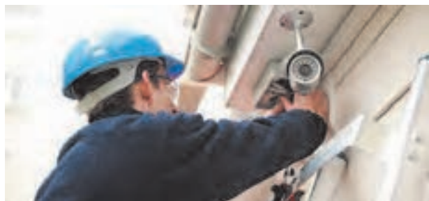
شکل ۲۹ - نصب دوربین در فضای مناسب
