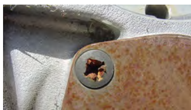
ب) استفاده ناصحیح از آچار پیچ گوشتی
