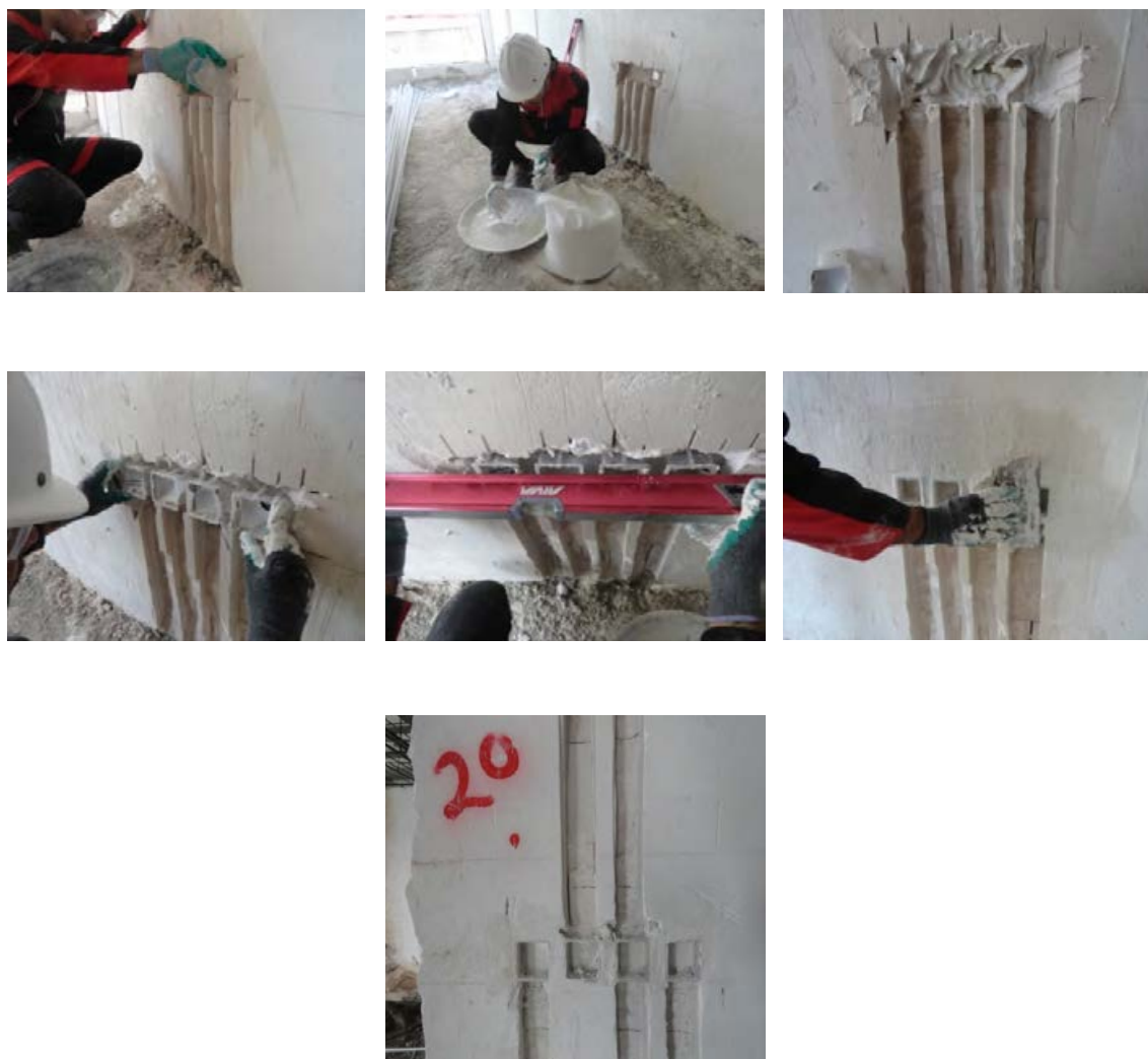
شکل ۳۷-۲- مراحل نصب قوطی کلید و پریرز
