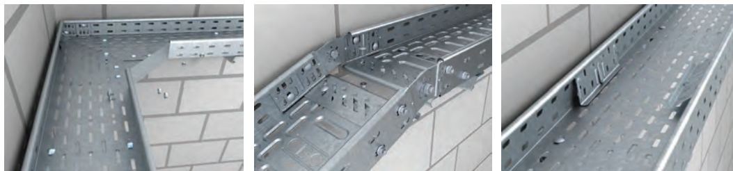
شکل ۴۴- اتصالات سینی کابل
