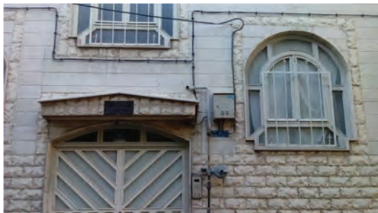
شکل ۱- کابل کشی روی دیوار
