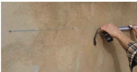
شکل ۳۴- تعیین محل نصب
