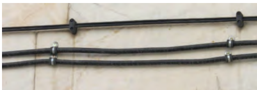
شکل ۲۷ - فاصله بین بست‌ها
