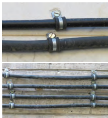
شکل ۲۵- کابل‌کشی روی دیوار
