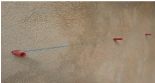
شکل ۳۵- نصب رول پلاک‌ها
