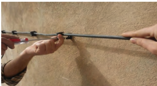
شکل ۳۷- کابل نصب شده روی دیوار
