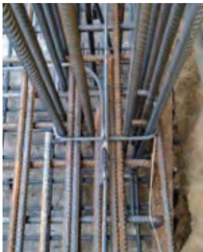
شکل ۲۲- جوشکاری میلگردهای شناژ با شالوده
