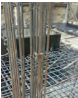
شکل ۲۷ - قطعه اتصال دهنده
