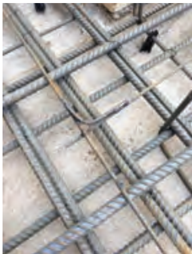
شکل ۲۱- جوش کاری میلگردها در تقاطع سه راهه
