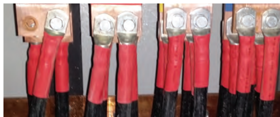
شکل ۱۷- عایق حرارتی کابلشو
