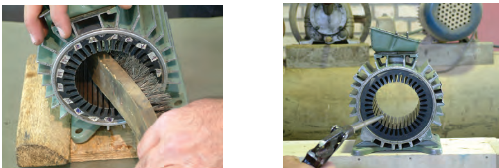
شکل ۲۵-۱ داخل شیارها را با برس تمیز کنید
