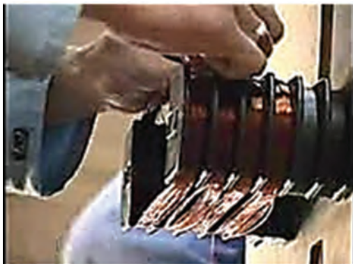
شکل ۳۴- بستن کلاف‌های پیچیده شده روی قالب
