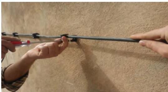
شکل ۳۷- کابل نصب شده روی دیوار
