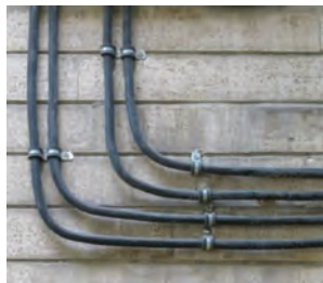
شکل ۲۱- خمش کابل
