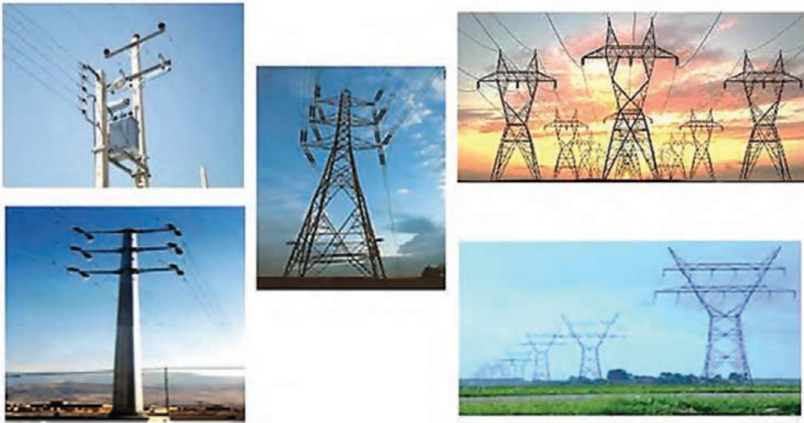
شکل ۱۲- پایه های خطوط انتقال انرژی الکتریکی
