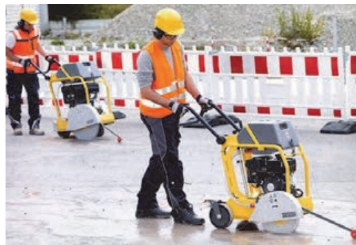
شکل ۱۷- دستگاه برش آسفالت دستی
