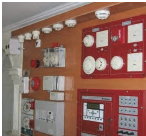
شکل ۹-۴- نمونه‌هایی از سیستم‌های اعلان حریق و کاشف‌ها
