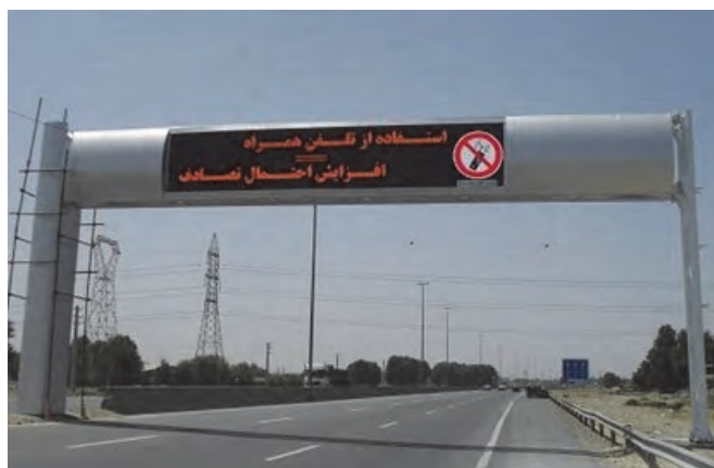
شکل ۱۶- نمایی از تابلوهای پیام متغیر
