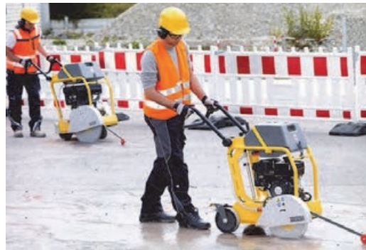
شکل ۱۷- دستگاه برش آسفالت دستی
