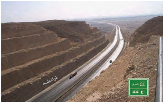
شکل ۹- ترانشه (شیروانی‌های خاکی اطراف راه)
