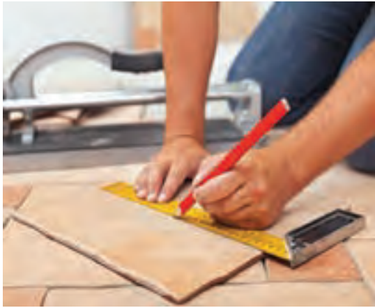
مشخص کردن مسیر برش سرامیک
