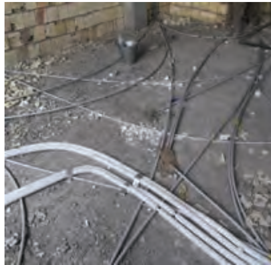
محکم کردن تأسیسات در کف قبل از بتن ریزی
