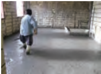
تسطیح فوم بتن قبل از خشک شدن
