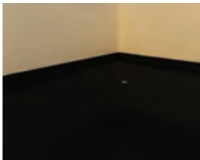
۲- اجرای قیر روی بتن شیب بندی
