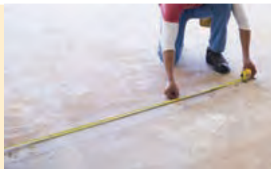
اندازه گیری کف برای تعیین مقدار مواد و مصالح
