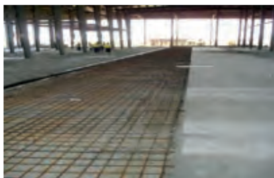
اجرای بتن کف
