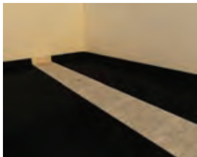
۱- آماده‌سازی کف قبل از اجرای عایق
