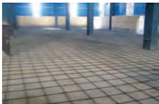
اجرای شبکه تقویتی میل‌گرد جهت فضاهایی که عبور و مرور زیاد یا بارگذاری سنگین روی آن انجام می‌شود.
