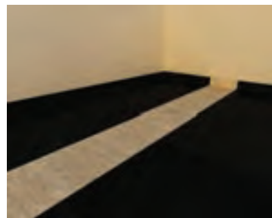
۹- اجرای لایه سوم قیر
