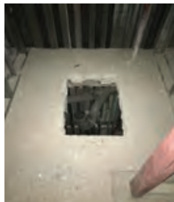
حفره جهت نصب سبد
