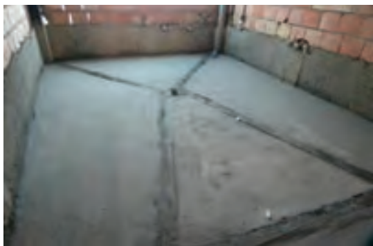
اجرای کرم و بتن شیب‌بندی حمام
