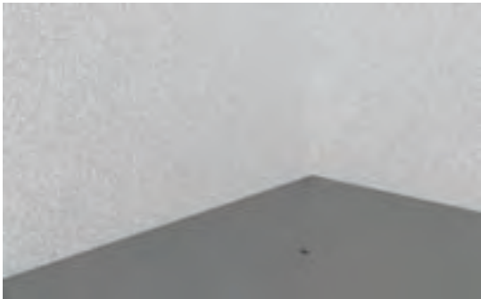
تکمیل بتن ریزی سطح
