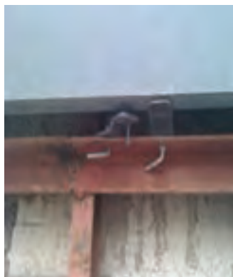
اتصال قطعات زیرسازی سنگ به دیوار
