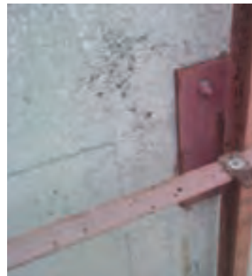
اتصال قطعات زیرسازی سنگ به دیوار
