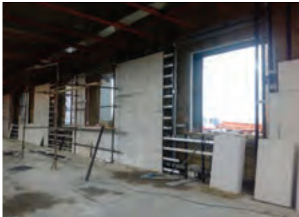
اجرای زیرسازی فلزی
