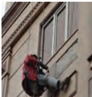
جدا شدن سنگ در صورت اسکوپ نشدن
