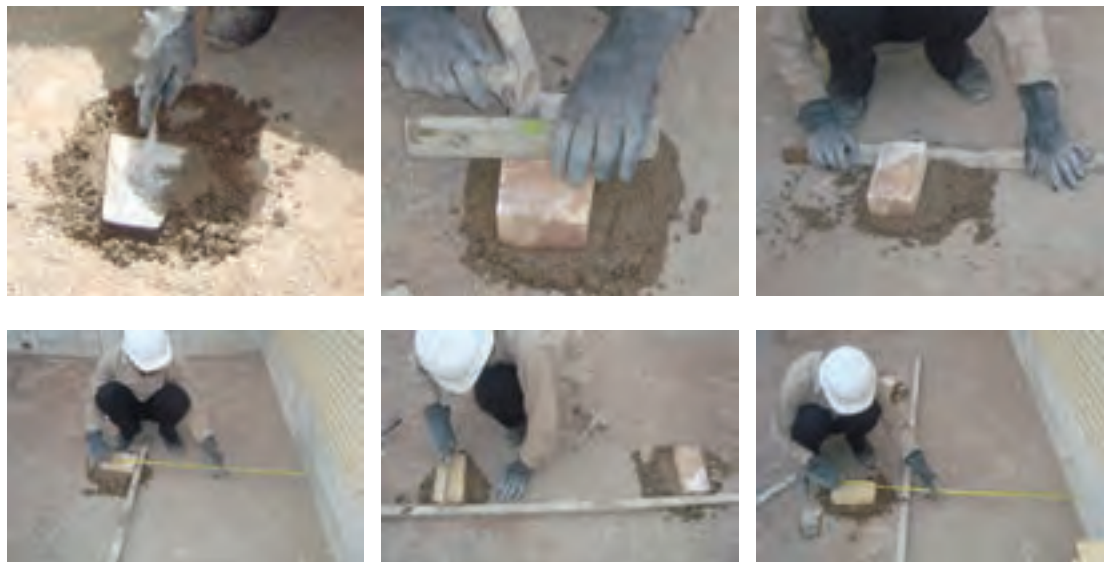
مراحل تعیین محل جداکننده
