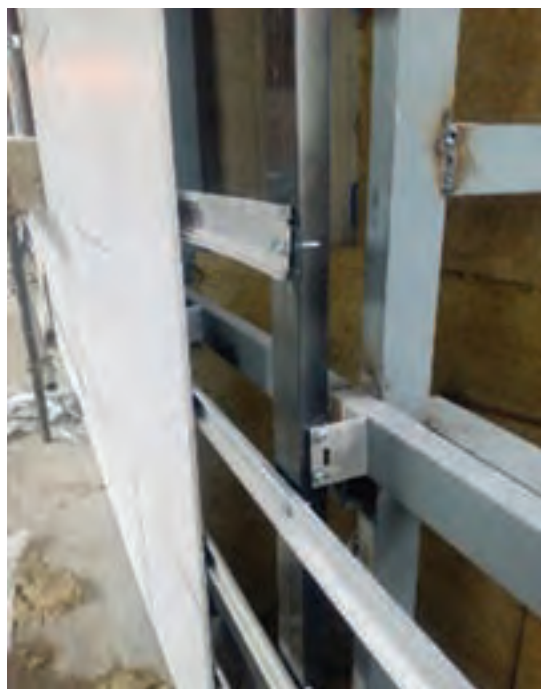
نمایی از اتصال قطعه به زیرسازی
