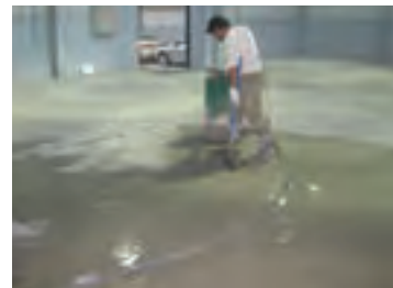
اجرای ملات برای مسطح کردن سطح
