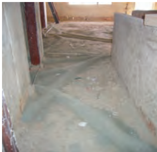
پوشش تأسیسات به منظور محافظت از آنها
