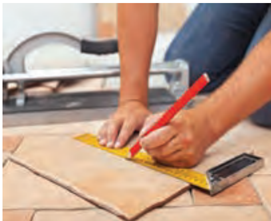
مشخص کردن مسیر برش سرامیک
