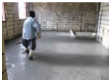
تسطیح فوم بتن قبل از خشک شدن
