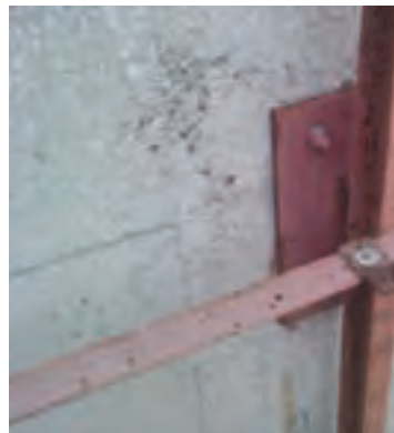
اتصال قطعات زیرسازی سنگ به دیوار
