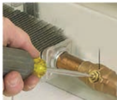
شیر هواگیری کنوکتور
