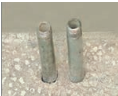
شکل لوله رفت و برگشت در کف
