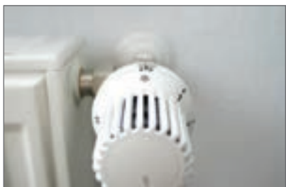
رادیاتور با شیر ترموستاتیکی
