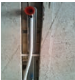
اتصال لوله به دیوار
