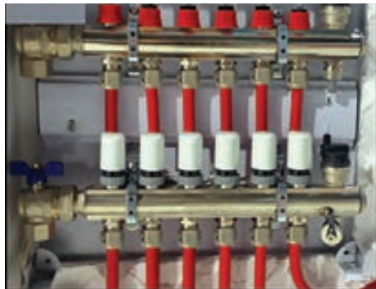
کلکتور سیستم کف گرمایی
