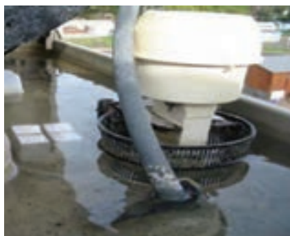
شیلنگ رابط پمپ و چهارراهی
