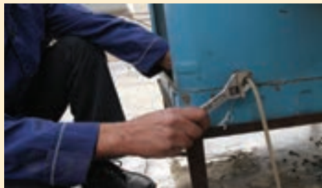
نصب لوله به شیر شناور
