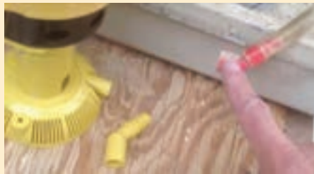
اتصال شیلنگ آب پخش‌کن به پمپ
