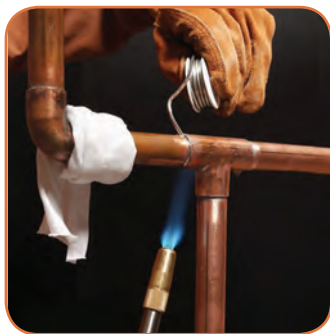
لجیم کاری نقره در لوله مسی
