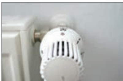
رادیاتور با شیر ترموستاتیکی
