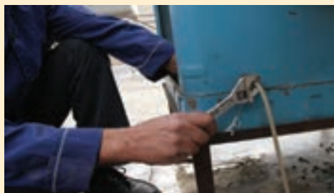
نصب لوله به شیر شناور
