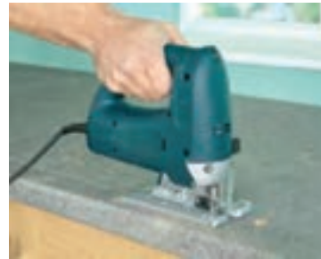
شکل ۱۰۱ - برش کاری محل قرارگیری سینک
