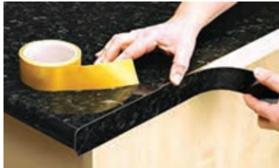
شکل ۱۱۹ - نصب نوار لبه صفحه تاپس
