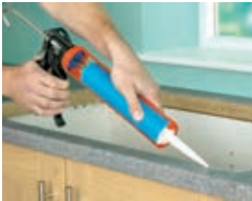
شکل ۱۰۳ - آب بندی لبه های زیرین سینک به کمک چسب آکوارיום
