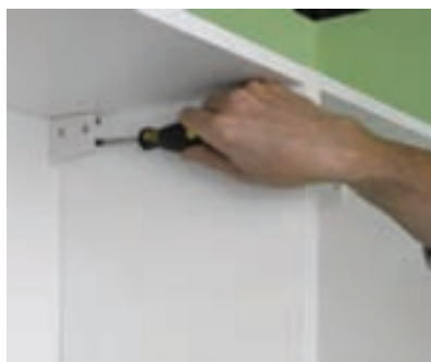
شکل ۲۳ - نصب کابینت با هنگر
