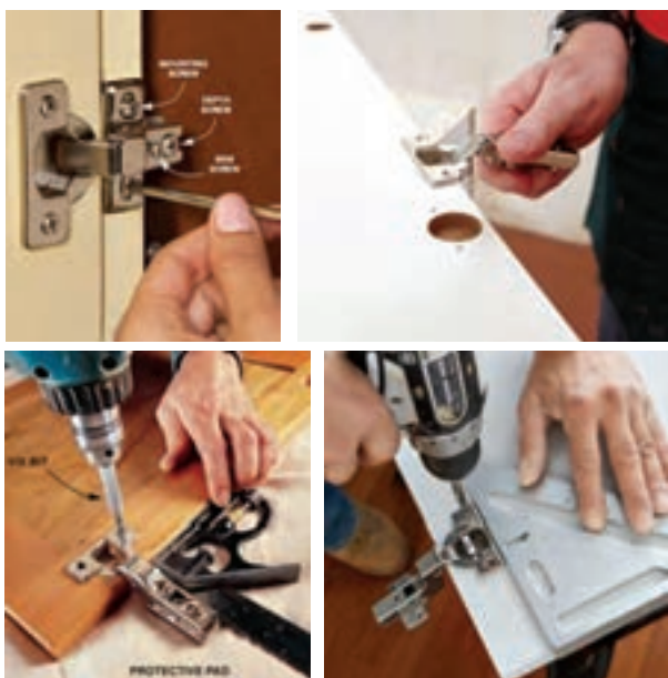
شکل ۴۹- نصب لولا روی در
