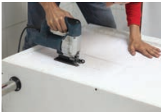
شکل ۱۲- نحوه درآوردن جای لوله‌های تأسیسات و پرز برق با اره چکشی
