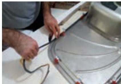
شکل ۱۰۴ - نصب نوار آب بندی پشت لبه سینک
