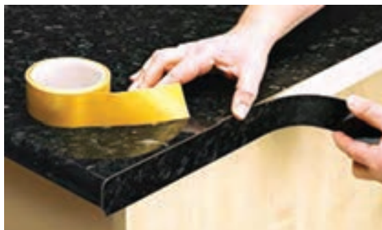
شکل ۱۱۹ - نصب نوار لبه صفحه تاپس
