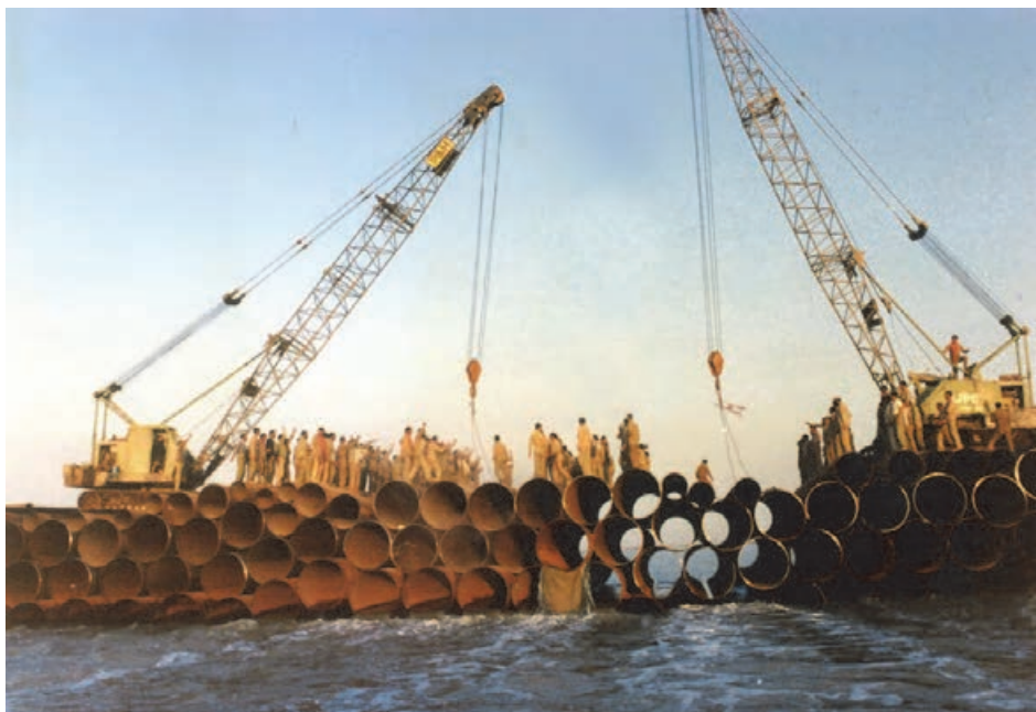
شکل ۱۱-۵- پل بعثت در حال ساخت
