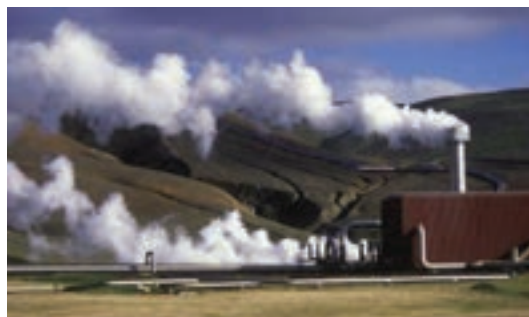
شکل ۱۸ - ۶ نیروگاه زمین گرمایی
