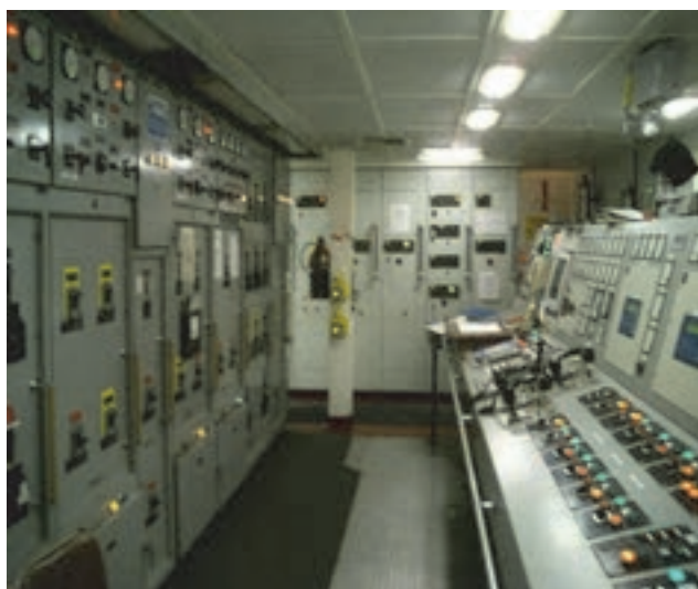
شکل ۳۶- تابلو توزیع یک شناور
