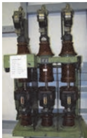
شکل ۱۶- کلید اکسپانزیون (آبی)
