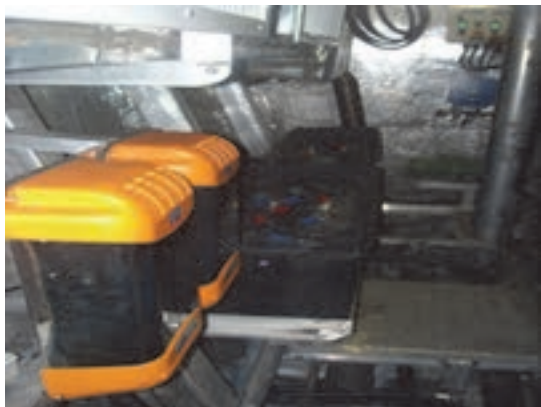
شکل ۷- مولدهای DC در شناورها
