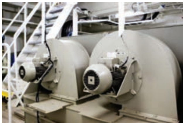
شکل ۲- دمنده سیستم تهویه
