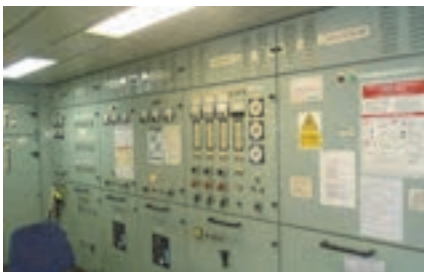
شکل ۱۶ - سویچ برد اصلی شناور
