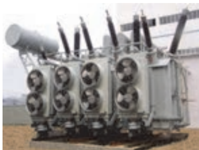
شکل ۳۹- ترانسفورماتور قدرت
