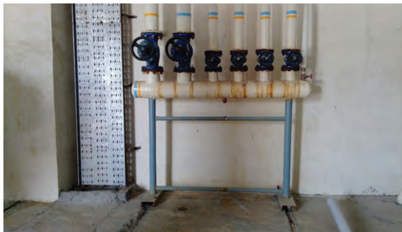
شکل ۲- نصب پایه کلکتور
