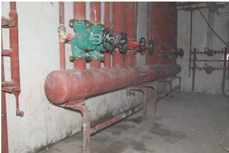
شکل ۱- نصب شیر تخلیه کلکتور
