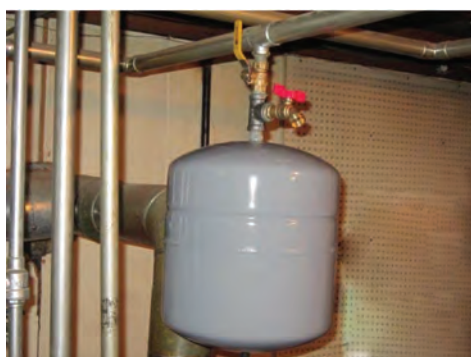
شکل ۲- مخزن انبساط بسته
