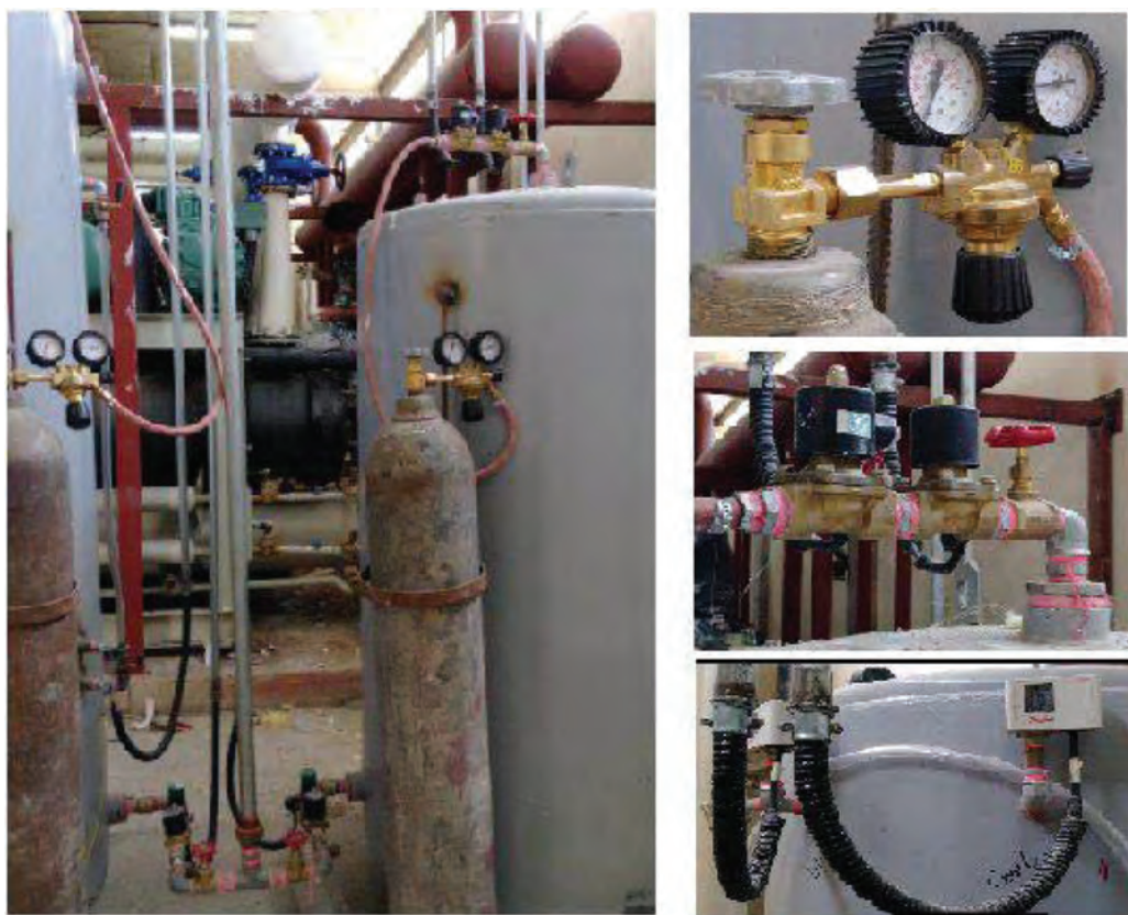
شکل ۲۳- مخزن انبساط بسته با متعلقات
