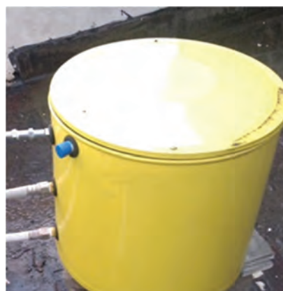
شکل ۳- مخزن انبساط باز با عایق
