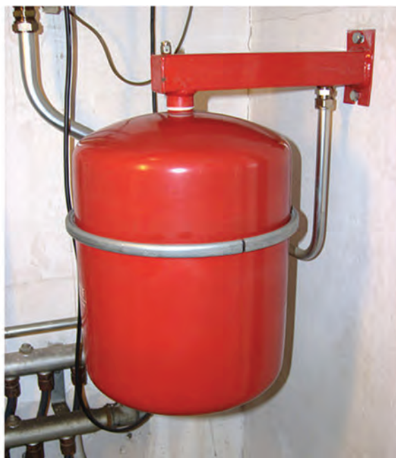
شکل ۱۶- استقرار مخزن انبساط بسته
