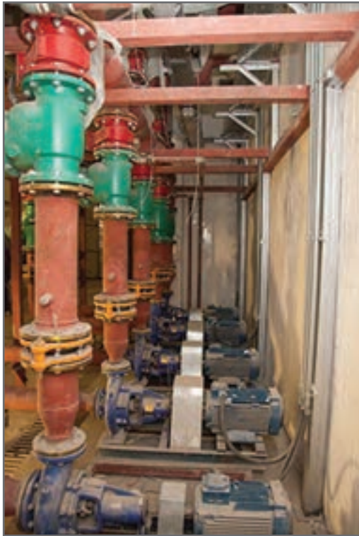
شکل ۳۲ - خط رانش پمپ زمینی
