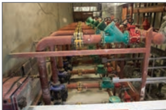
شکل ۳۳- خط مکش پمپ زمینی
