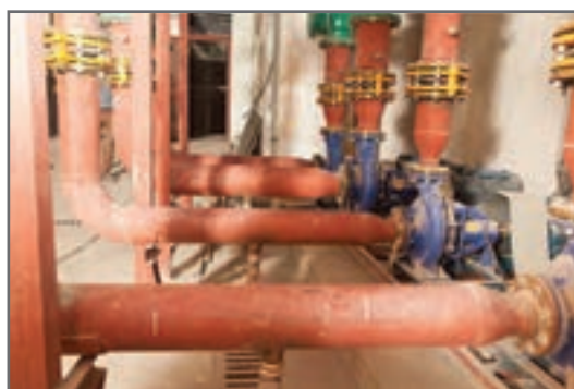
شکل ۳۳- خط مکش پمپ زمینی
